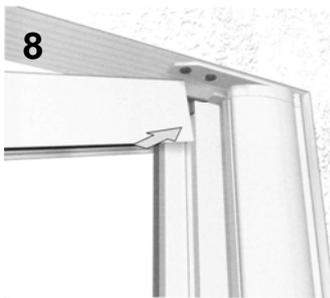
Insérer la coulisse d'abord sur le caisson B.
