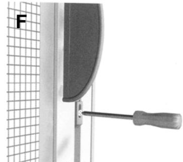
En partie basse, desserrer légèrement la vis au niveau de la poignée. Repousser le stopper à fond dans le verrou et resserrer à fond la vis.
